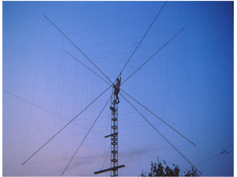
Foto izq. Antena cúbica en proceso de ensamblado. Foto dcha. Domingo Gil EASTX en lo alto de la torre. Observar la proporcionalidad hombre-antena.
