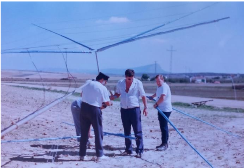
En la foto de la izquierda, la antena todavía en el suelo. Están ensamblando las aspas de fibra de vidrio. En la foto de la izquierda la antena ya erigida. De izq. a derecha. Persona desconocida, Francisco Vicens EA5EHM , Rafael Sancho EA5DTX y Domingo Gil EA5TX . Fotógrafo Pascual Avellana EA5CNP
