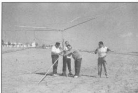
Colocación cañas a cuadro elemento reflector de la quad.
