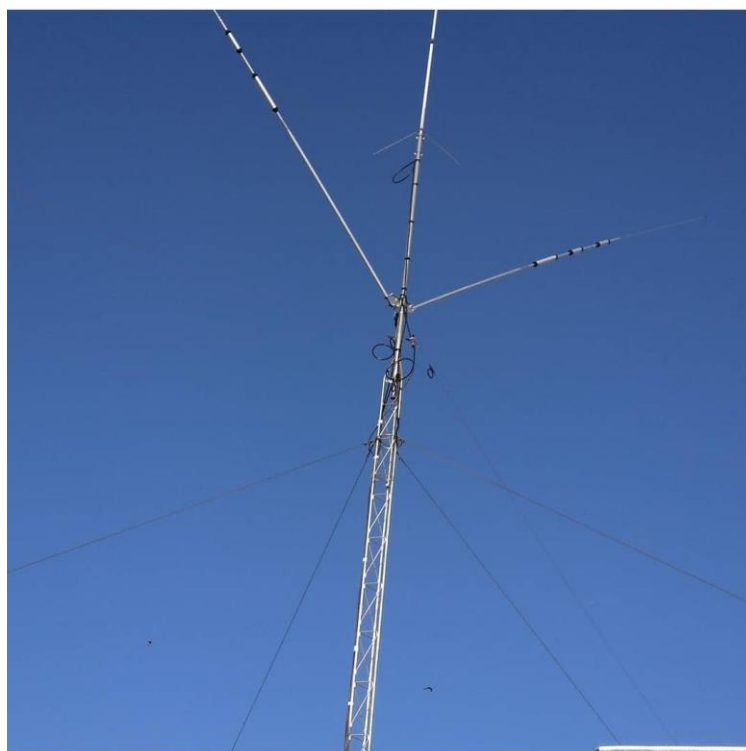
Dipolo rígido Comet H422 instalado en Cabanes (CS) por Rafael Sancho EA5DTX
