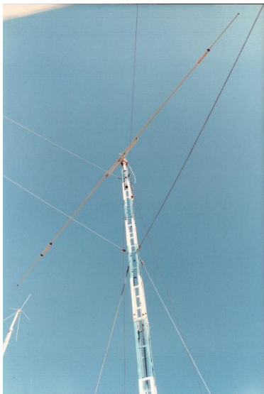
Antena Dipolo Rígido y dipolo trombón utilizados desde 1983 hasta 1990
