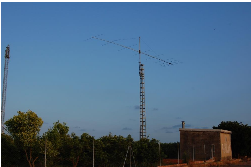
Antena yagi de 8 elementos y 12 metros de boom para la banda de 50 mhz. Posteriormente fue sustituida por la direccional de las bandas warc y por una más pequeña para la banda de 50 mhz.
