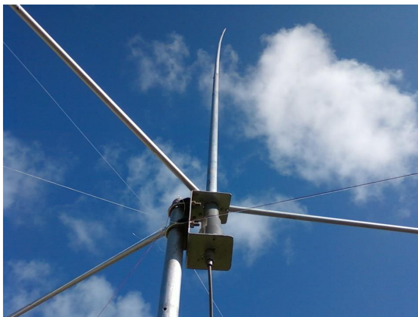
Antena vertical de 5/8 lambda, para la banda de 27 mhz, típica de las instalaciones de la banda C.B. en los años 70/80.
